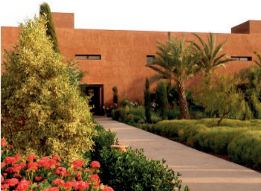
Figure 3.- Bâtiment à Marrakech.
