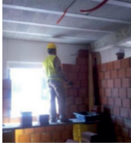
Figure 31.- Soulèvement de la paroi intérieure. (Source: ADEREE)
