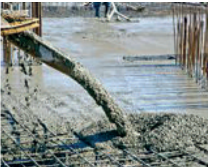
Figure 6.- Dalle en béton
