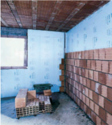
Figure 27.- Mise en place des plaques de XPS dans la double cloison.
