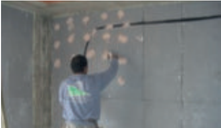
Figure 42.- Peltées pour l'adhésion des plaques de plâtre laminé. (Source: ANAPE)
