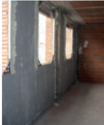
Figure 40.- Paroi totalement isolée par l'intérieur. (Source: ANAPE)
