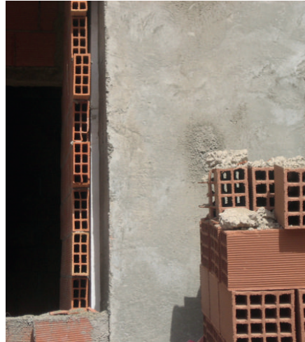
Figure 28.- Mise en place de l'isolant dans la lame d'air de la double cloison. (Source: ADEREE)
