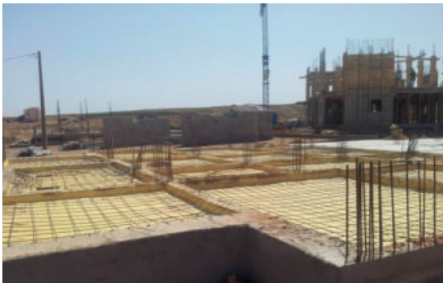
Figure 51.- Isolation du plancher avec du polyuréthane projeté (PUR). (source: ADEREE)
