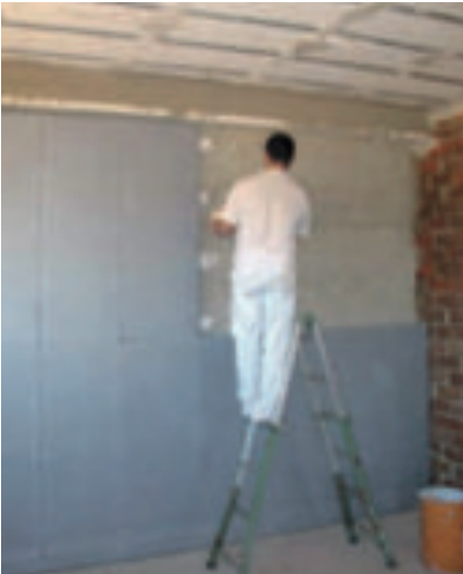
Figure 39.- Mise en place des plaques du polystyrène. (Source: ANAPE)
