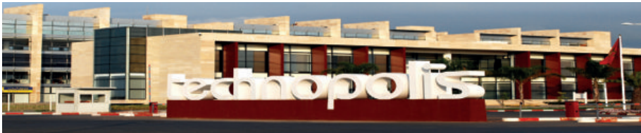
Figure 14.- Parc Technologique Technopolis à Rabat
