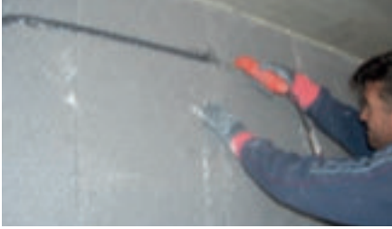
Figure 41.- Réalisation des emplacements pour encastrer les câbles électriques. (Source: ANAPE)
