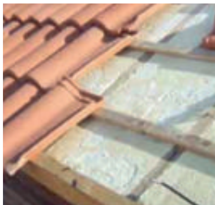
Figure 24.- Mise en place des tuiles (Source: ANAPE)
