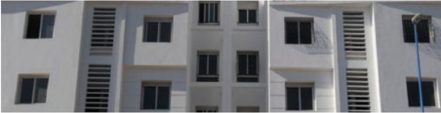
Figure 9.- Bâtiment résidentiel collectif Moyen Standing (Source: ADEREE)
