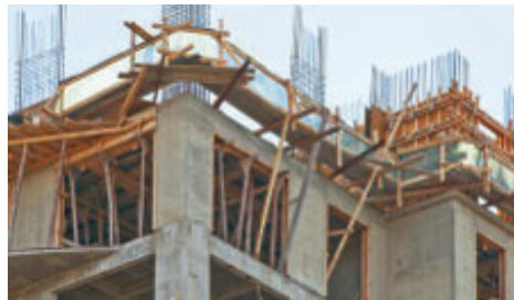
Figure 7.- Chantier de construction: Dalle porteuse en béton (l'étage supérieur en phase de coffrage). On peut observer les armatures métalliques pour la structure de l'étage supérieur.
